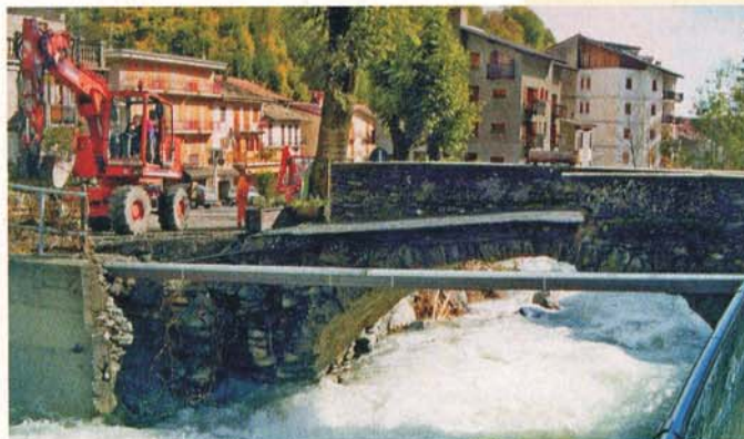
Figura 2.146 ◆ Comune di Crissolo, capoluogo. Il Po determina gravi danni al ponte ad arco in pietra, in seguito abbattuto.
