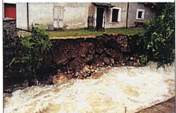
Figura 56 - Crissolo erosione in destra del F. Po. Il deflusso è verso sinistra. (VP07)
