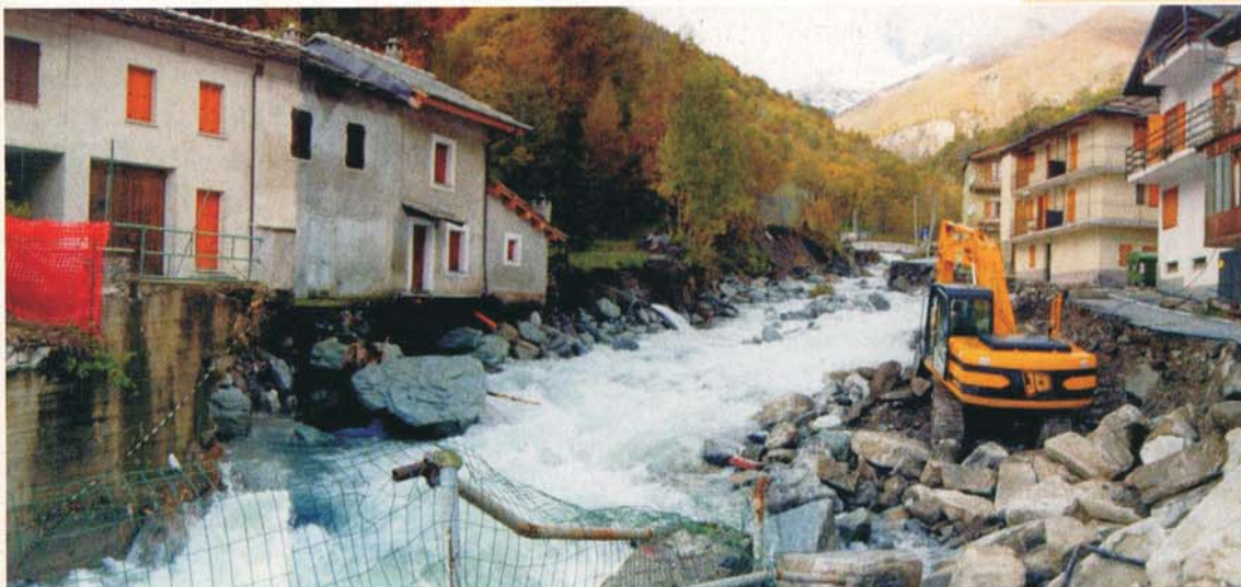
Figura 2.145 ◆ Comune di Crissolo, capoluogo. Il Po si amplia con erosione delle sponde in destra ed in sinistra, asportando strade ed infrastrutture. Gravi danni ad alcune abitazioni (a sinistra nella foto), parzialmente private del piano di appoggio.
